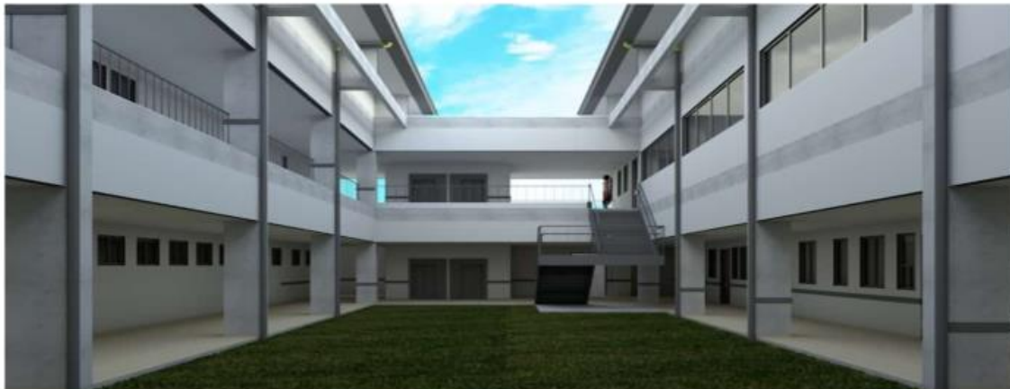
PATIO INTERIOR NUEVO HOSPITAL SAN JUAN BAUTISTA
